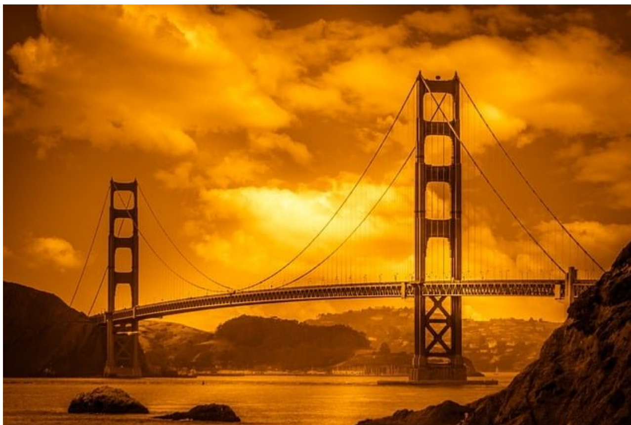
Ponte Golden Gate – São Francisco, Califórnia, Estados Unidos
